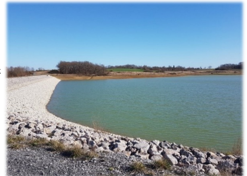
Réservoir de la Barne
