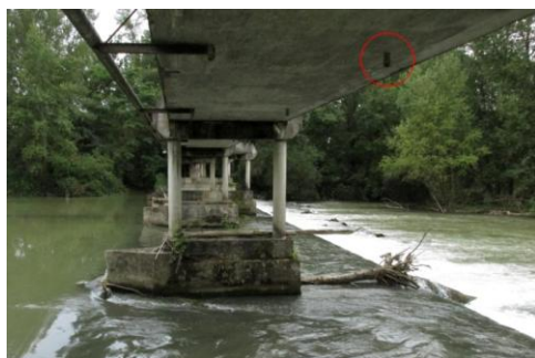
Pont en béton à Jû-Belloc (32) : favorable Entouré en rouge : un drain, gîte potentiel.
