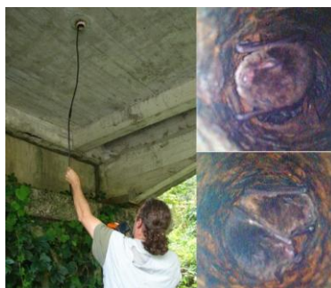
Inspection des drains à l'endoscope et photos de Murins de Daubenton.
