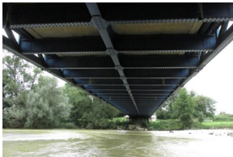
Pont à structure métallique à Riscle (32) : non favorable
