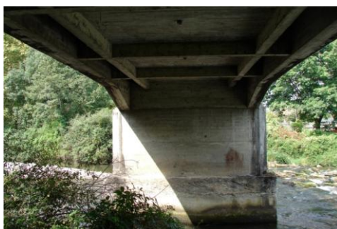
Pont en béton à Aurensac (65) : favorable
