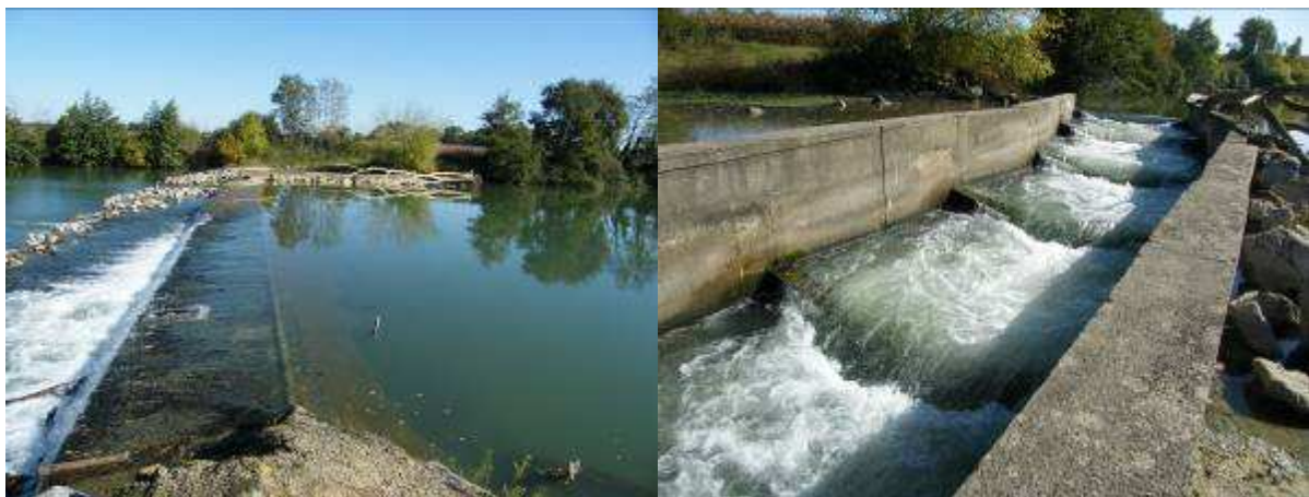
Photos 48 et 49 : Seuil établi en lit mineur de l'Adour avec sa passe à poissons
