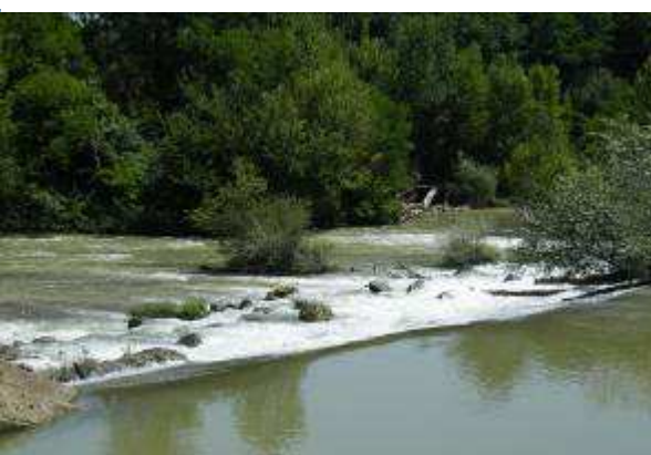
Photo 67 : Zoom sur le déversoir
