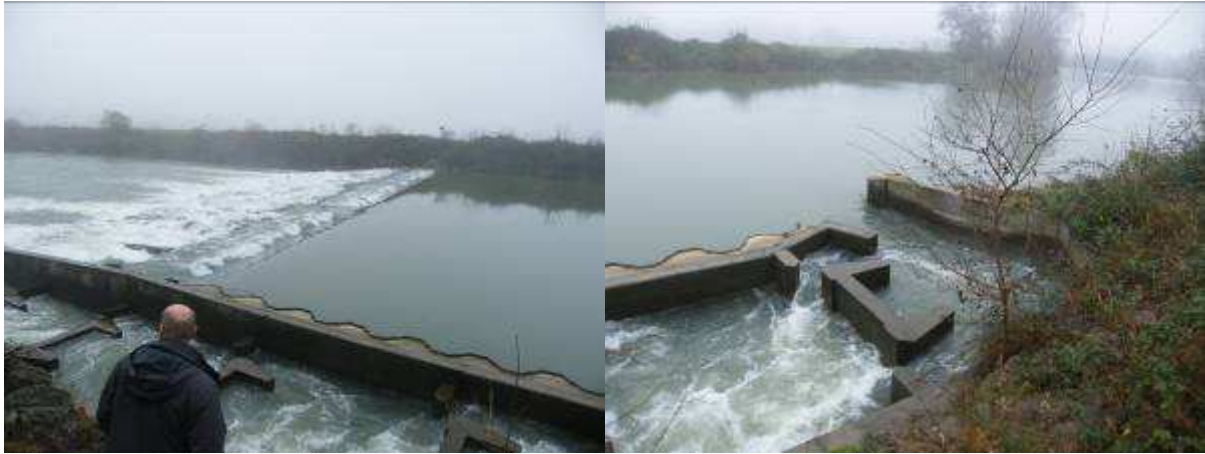
Photos 53 et 54 : Seuil d'Augreilh et sa passe à poissons par bassins
