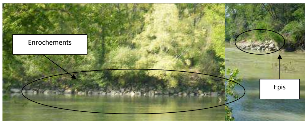
Photo 44 et 45 : Enrochement et épis
