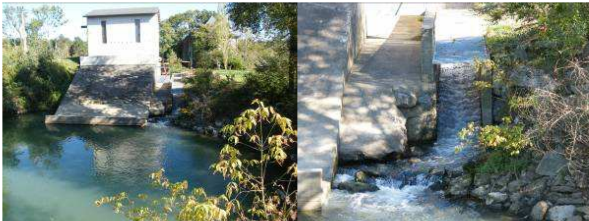
Photos 50 et 51 : Microcentrale d'Onard avec sa passe à poissons
