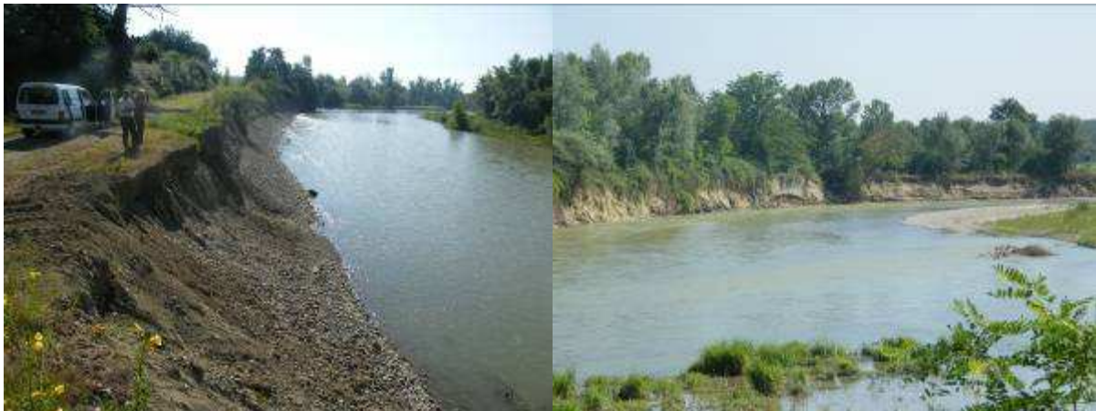
Photos 38 et 39 : Erosion de berges à Bordères
