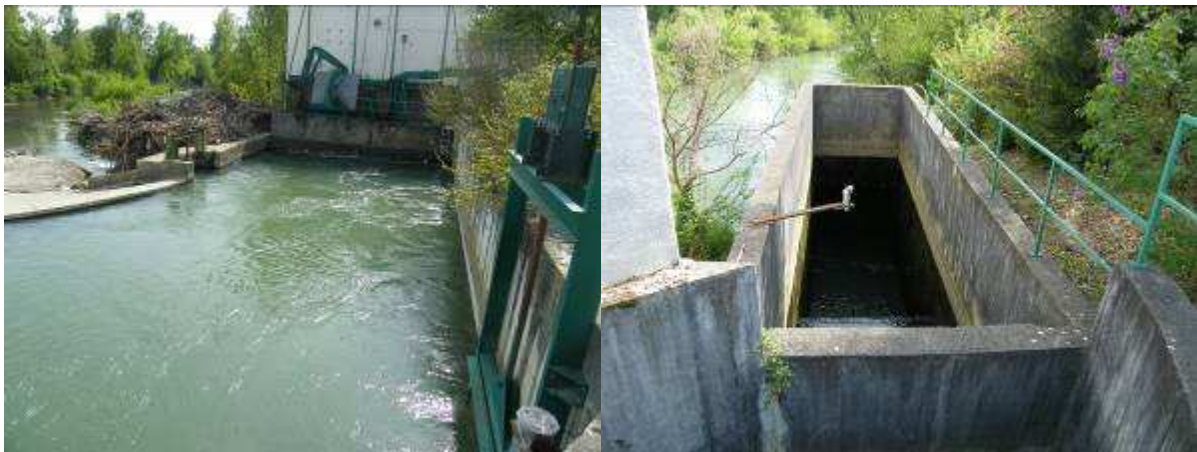
Photos 57, 58, 59 et 60 : Seuil de Saint-Maurice, érosion régressive, microcentrale et passe à poissons
