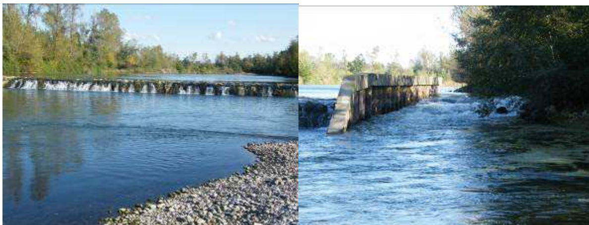
Photo 52 : Seuil de Toulouzette et sa passe à poissons rustique
