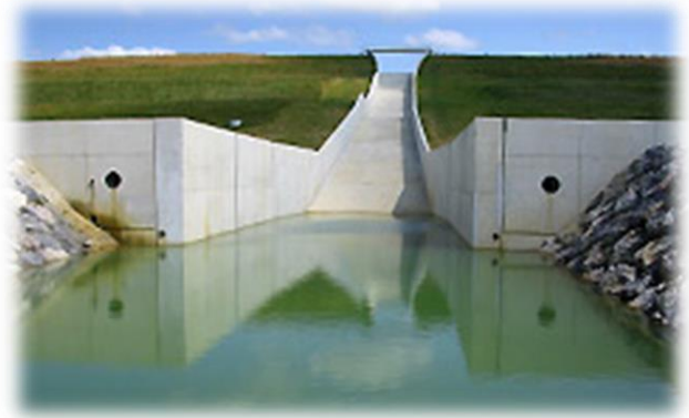
Figure 13. Ouvrage de stockage d'eau © Institution Adour
